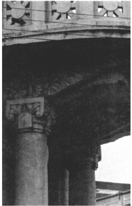
Cine- Teatro Oberdan. Detalhe da Arquitetura (1977)
